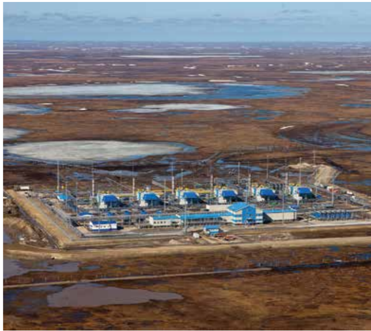
Компрессорная станция «Байдарацкая» Источник: Газпром
