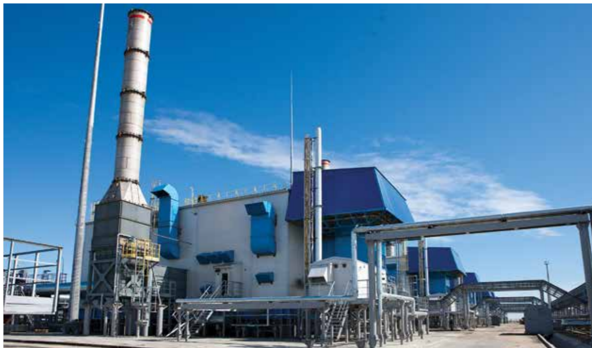
Компрессорная станция «Байдарацкая»
